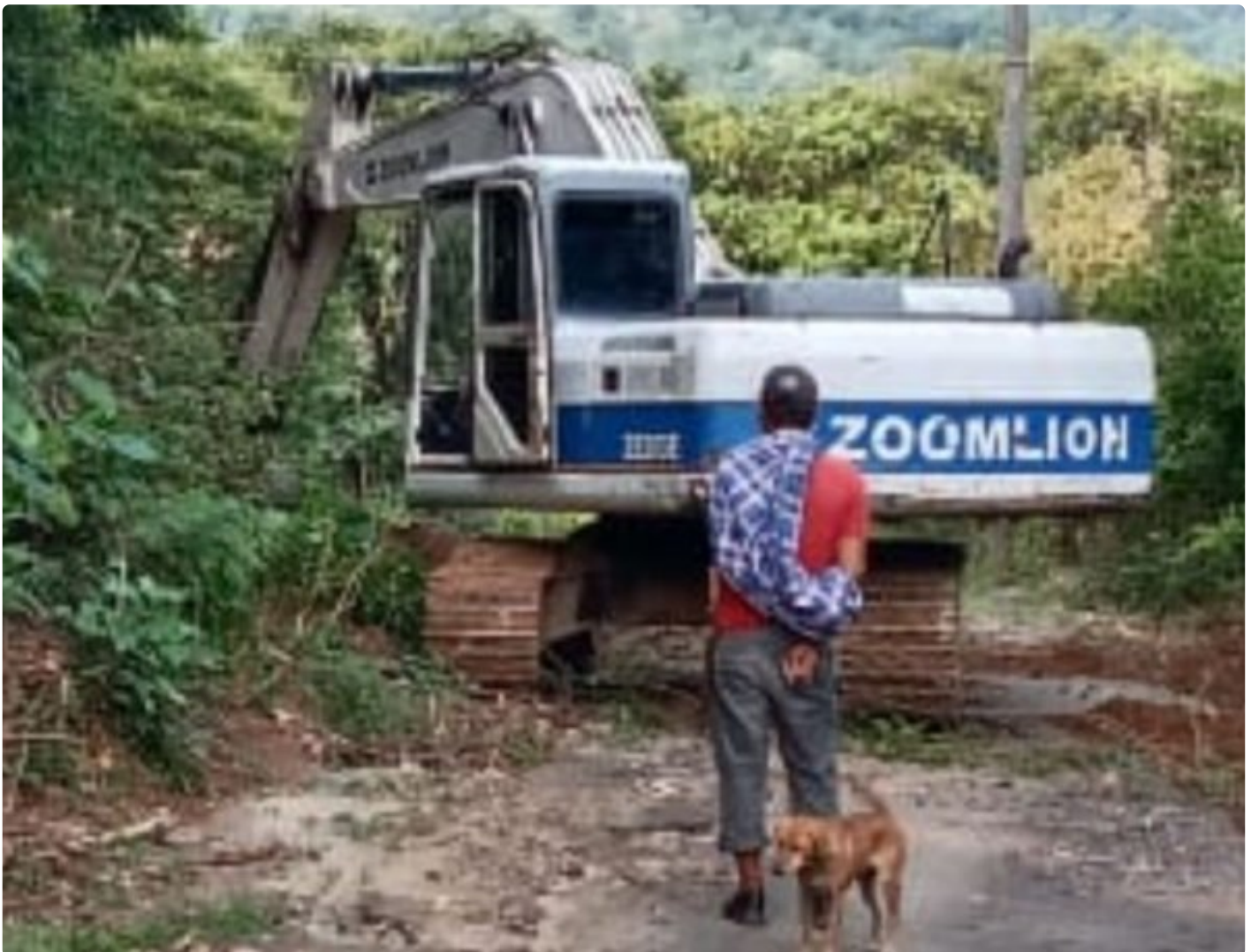
Owner Pujananting Group Muh. Arif Kerahkan Alat Beratnya Perbaiki Jalan Punranga - Gattareng
